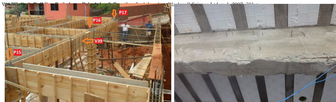
Viga com trincas e concreto se soltando (Fonte: Os autores).
