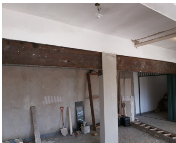
Viga com trincas e concreto se soltando (Fonte: Os autores).
